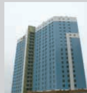
Жилой дом, Балашиха, МО. Сталь, S=13 135 м 2 Арх.бюро: «Мортон»
