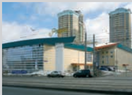
Центр фигурного катания Е.А.Чайковской, Москва, Строгино. Алюминий, S=7 200 м 2 Арх.бюро: «Моспроект-4»
