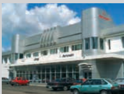
Автотехцентр, Москва. Алюминий, S=1 500 м 2
