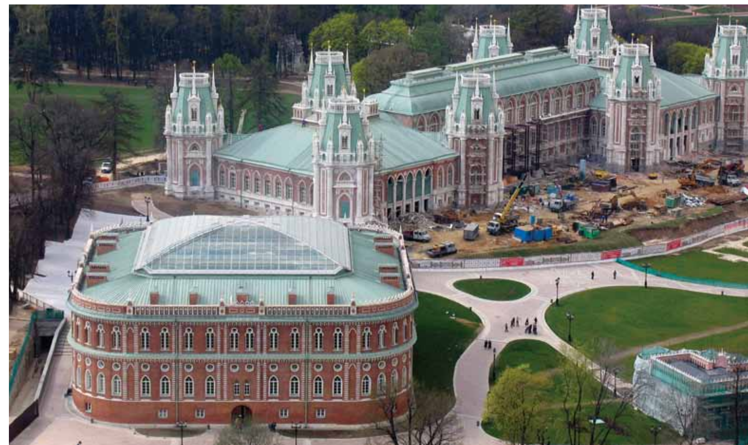
Большие площади с длинными кровельными картинками, произведенными из патинированной в заводских условиях меди Нордик Грин на кровле дворцовых зданий в Царицыно в Москве.
